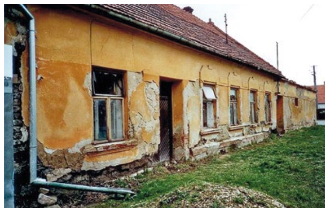
pekárna Františka Teplého, Žatčany č.p. 36 před zbouráním
